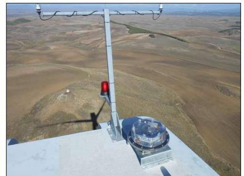
La Baliza de Media Intensidad para la señalización de obstáculos desarrollada por SAPREM está diseñada para señalizar al tráfico aéreo la presencia de obstáculos.
